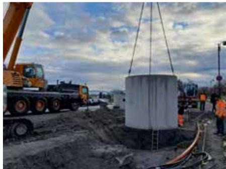
Die Straßenentwässerung mit dem Ölabscheider wurde eingebaut.
