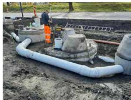
Im Zuge dessen wurde auch die Straßenentwässerung und der Ölabscheider eingebaut.
