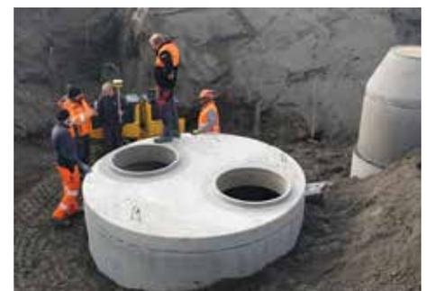
Es erfolgte ein weiterer Einbau eines Ölabscheiders und die Straßenentwässerung wurde errichtet.
