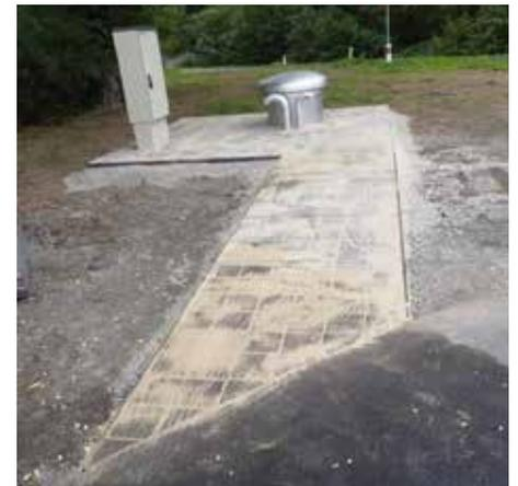
Pflasterarbeiten beim Trinkwasserübergabeschacht Höchst-Gaibau
