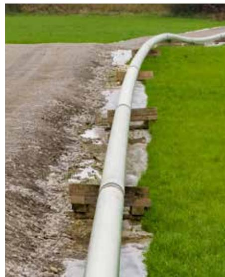
*Die Leitung wurde in Lustenau vorbereitet und verschweißt, sämtliche Verbindungen wurden gegen Korrosion geschützt. Alle Arbeiten wurden im Schutze eines Zelttes ausgeführt.*
