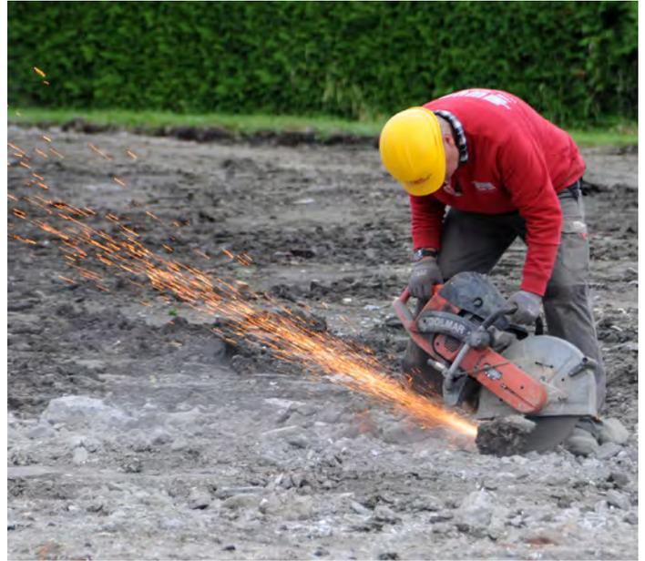
Bei den Abbrucharbeiten wurde strikte Materialtrennung vorgeschrieben. Hier wird Baustahl von Betonresten getrennt.
