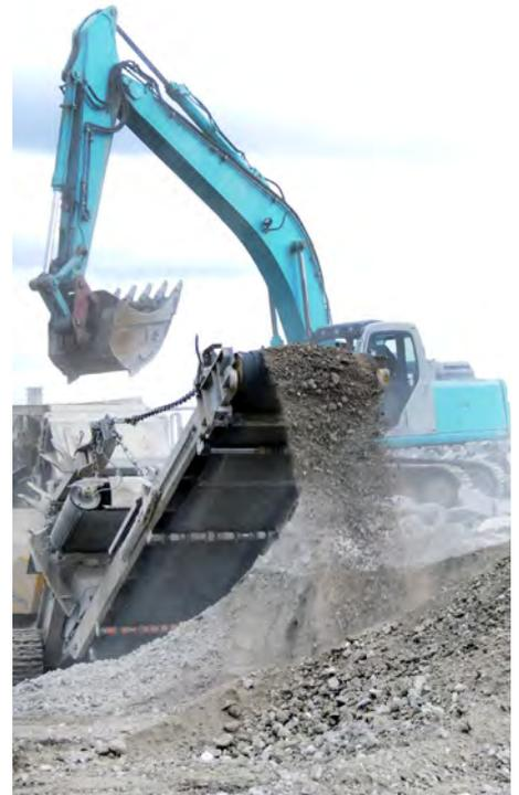
Der recycelte Bauschutt bleibt als stabilisierender Untergrund auf der Baustelle.
