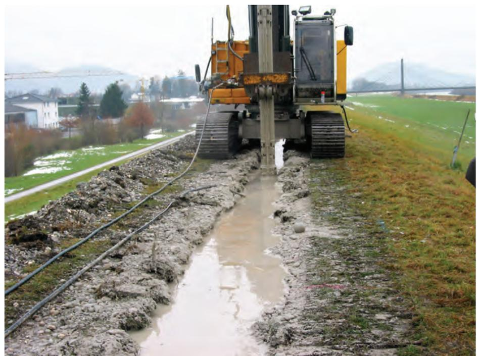
Die Dichtwand, die in der Mitte des Rheindammes eingebracht wird, reicht bis in 7 m Tiefe.
