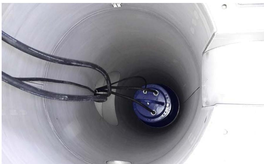
Die Tauchpumpe in ihrer Endposition im Stahlschacht
