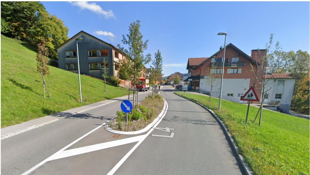
Abb. 9: Beispiel Torsituation / Bremsinsel L4 in Doren (Quelle: Google Street View 10/2022)
