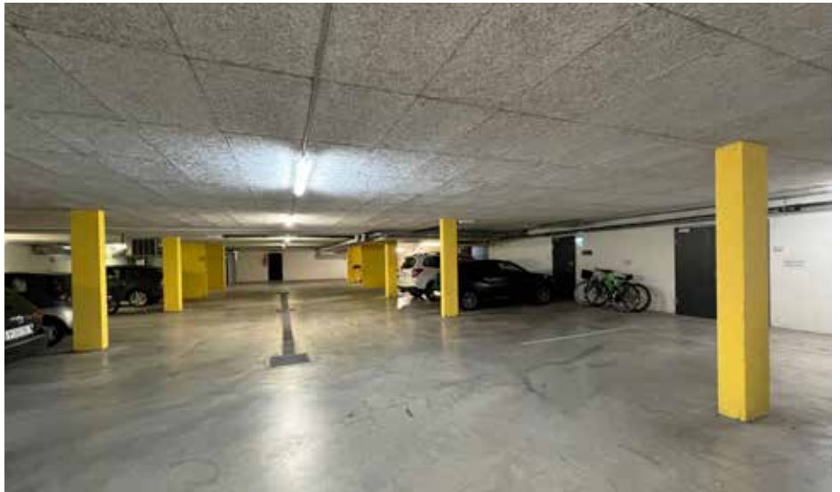
Eine nicht öffentliche Tiefgarage befindet sich zur Hälfte unter dem Pfarrzentrum.
