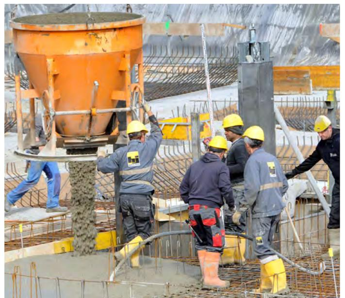
Laufend wird Fertigbeton angeliefert und ausgebracht.
