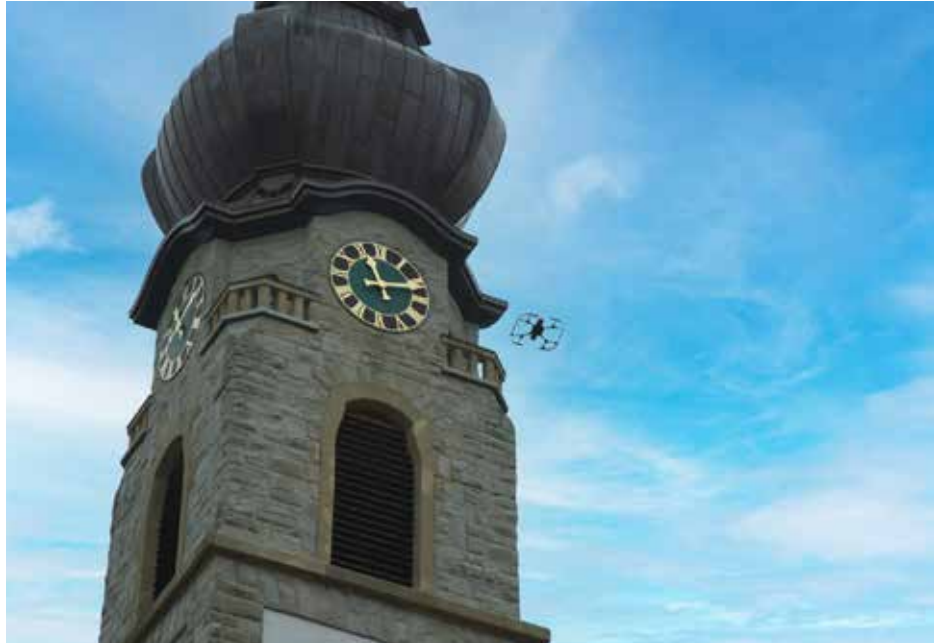
Die gesamte Aussenansicht der Kirche wurde per Drohne gescannt,
